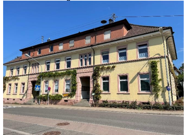
Bestandsgebäude Rathaus Rammersweier
