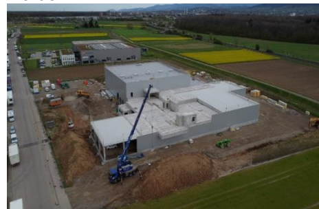
Neubau Fa. FGS im Gewerbepark hoch 3 (Foto: FGS Baden eG)
