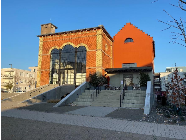
Eröffnung Kesselhaus im Mühlbachquartier
